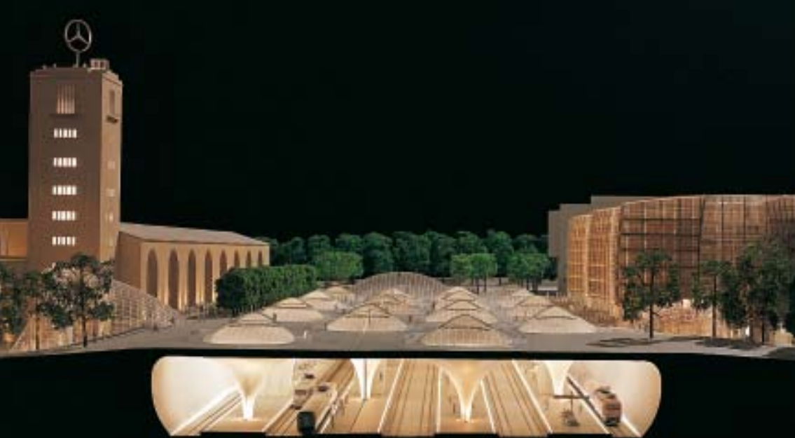
Der neue Bahnhof: eine Art U-Bahn-Station unten, oben eine kühle Landschaft mit Lichtschächten
